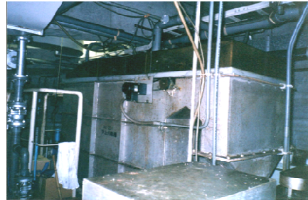
加圧浮上装置 → 改修後撤去
