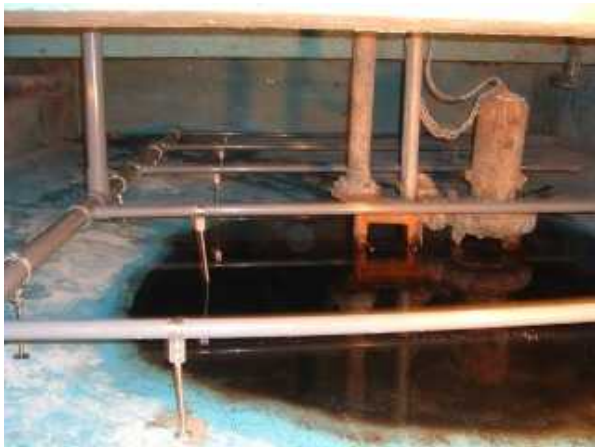
バイオ反応槽内散気管敷設状況
