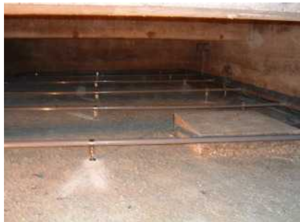
バイオ反応槽内散気管敷設状況
